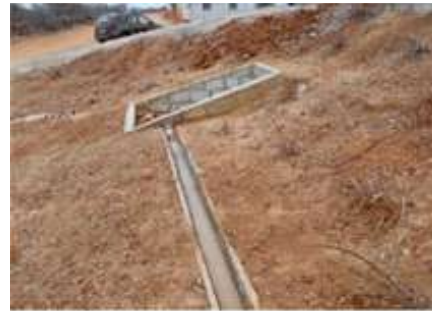
Controle de erosão e assoreamento - implantação do sistema de drenagem em talude, para coleta e direcionamento das águas
