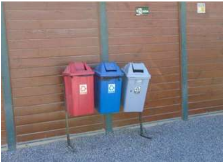
Exemplo de medida do Plano Ambiental da Construção (PAC): gestão de resíduos sólidos - coletores seletivos espalhados no canteiro de obras, contendo placas de identificação por tipo de resíduo e padrões de cores.
