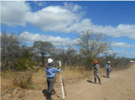
Exemplo de medida de controle de supressão - equipe de topografia demarcando o perímetro das áreas a serem suprimidas.
